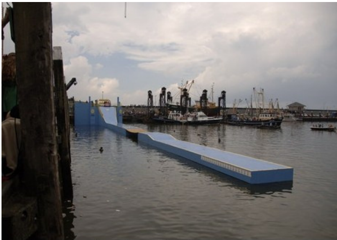
lage steiger vissershaven Den Oever
