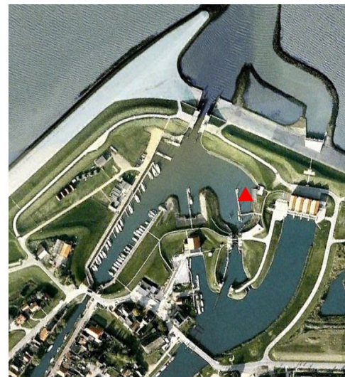
overzicht startplaats jachthaven Termunterzijl
