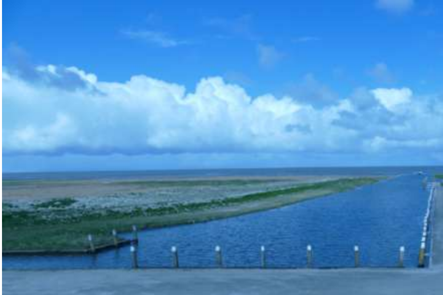
fig. 3. Haven van Noordpolderzijl 23-4-2016, vlak na hoogwater
